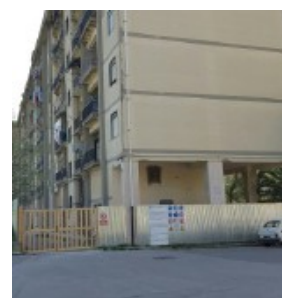
Le abitazioni di via Puccini sgomberate perché pericolanti
